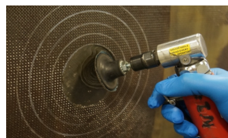
复材损坏修复测量
